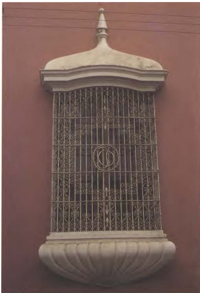
Ventana de casa de Trujillo del Perú
