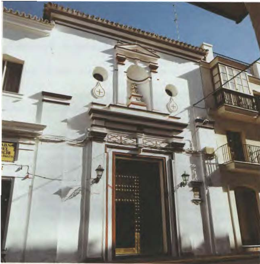
Fachada Iglesia de San Jorge. S. XVIII. Antiguo Colegio de los ingleses. Sanlúcar de Barrameda
