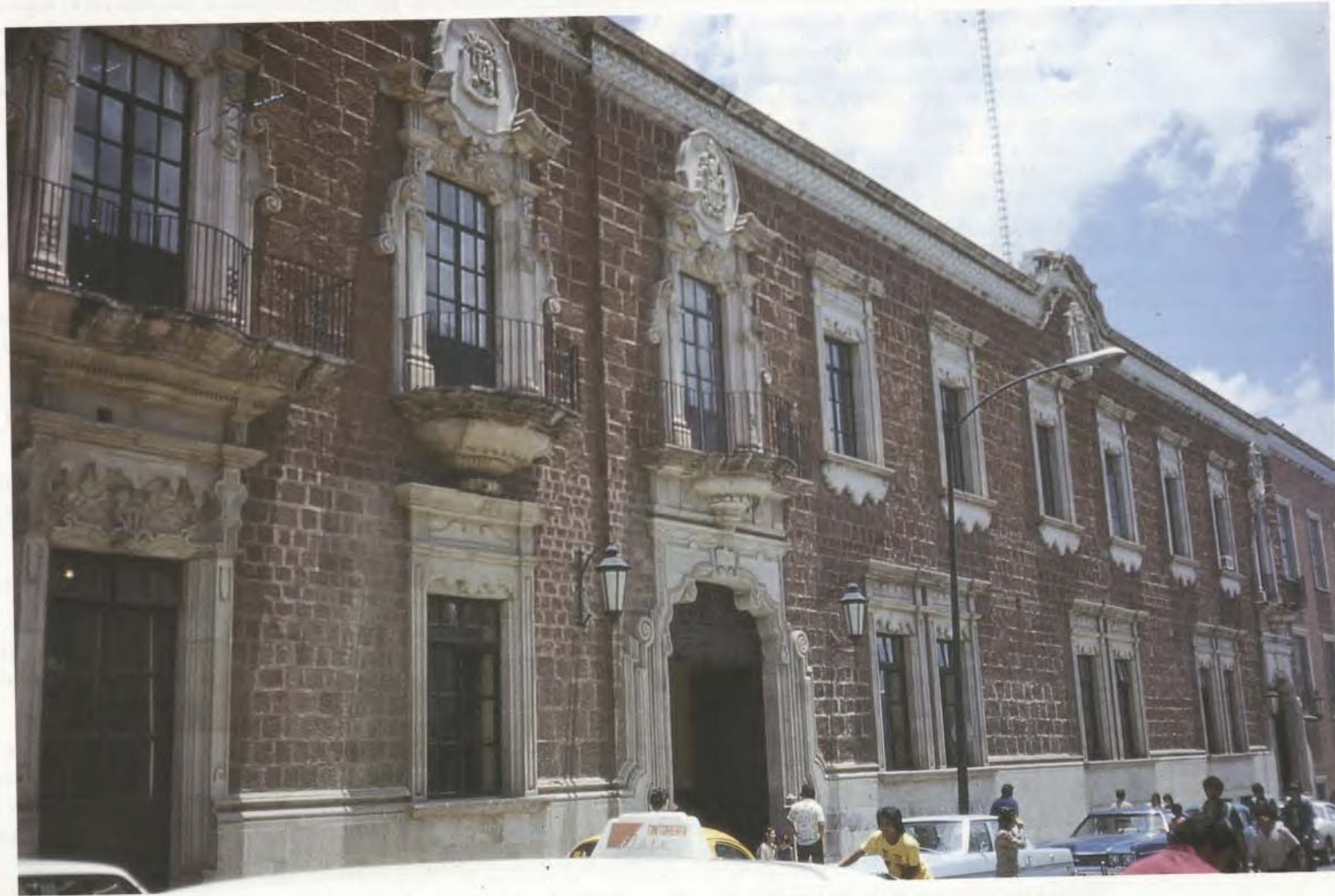
Palacio de Gobierno. Aguascalientes. México
