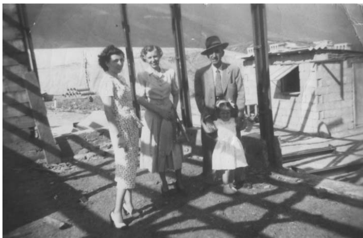
Imagen 2: Rafael Bergamín, su esposa Elvira, su hija Viruchy y su nieta Elma en las obras de la Casa Bergamín. Caracas, 1950 (Fuente: Archivo de Viruchy Bergamín).
